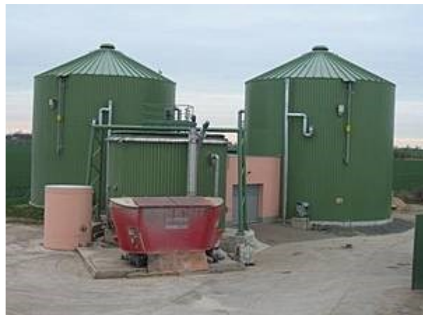
Biogasanlage Zschettgau, Foto: Landgut Zschettgau GmbH
