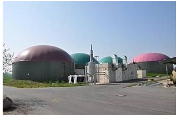
Biogasanlage Ochelmitz, Foto: Agrargenossenschaft Jesewitz eG
